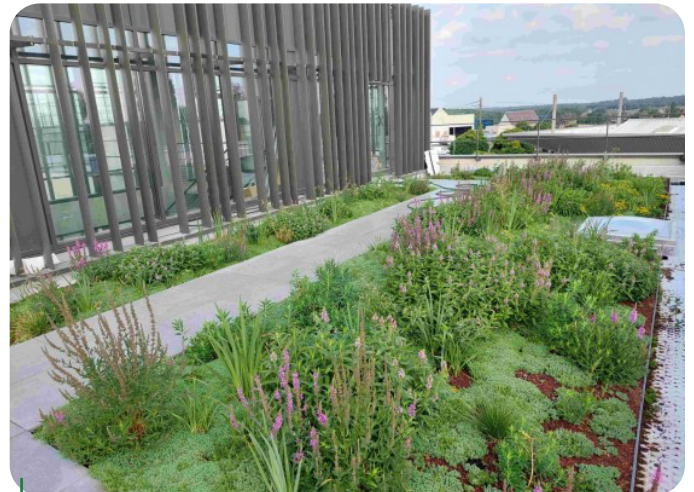
Toiture terrasse à Luynes ©SOPREMA
