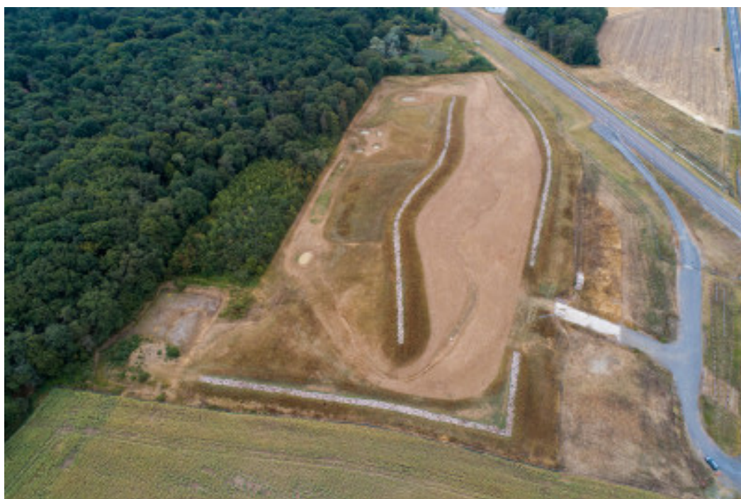
Site de mesure compensatoire proche de la LGV après travaux
