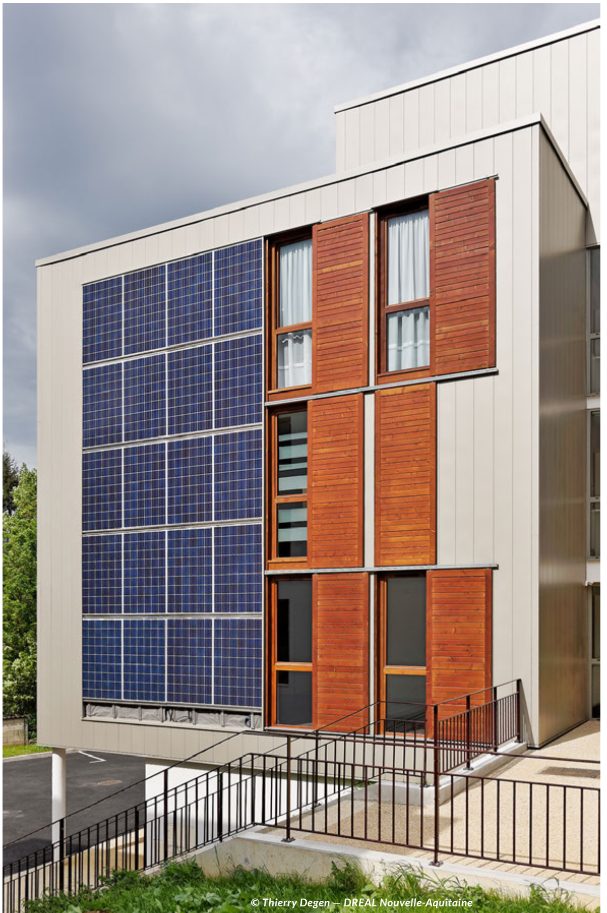
Panneaux photovoltaïques sur bâtiment existant
